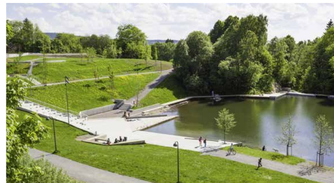
NATURRENSING AV FORURENSET GRUNN VED GRORUDDAMMEN. FOTO: OSLO KOMMUNE
